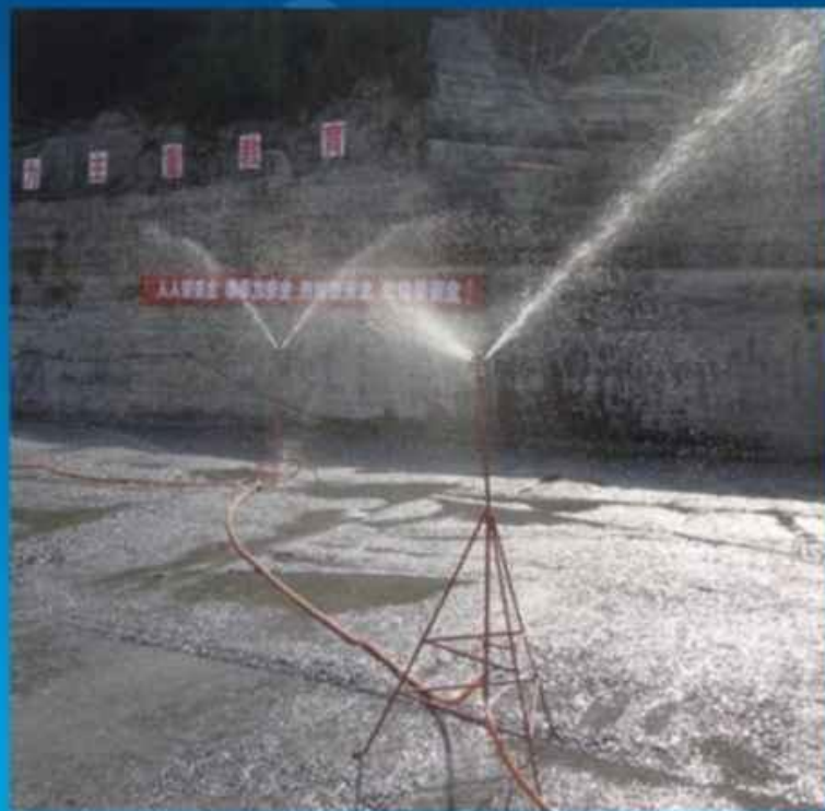
夏季混凝土面喷水养护
