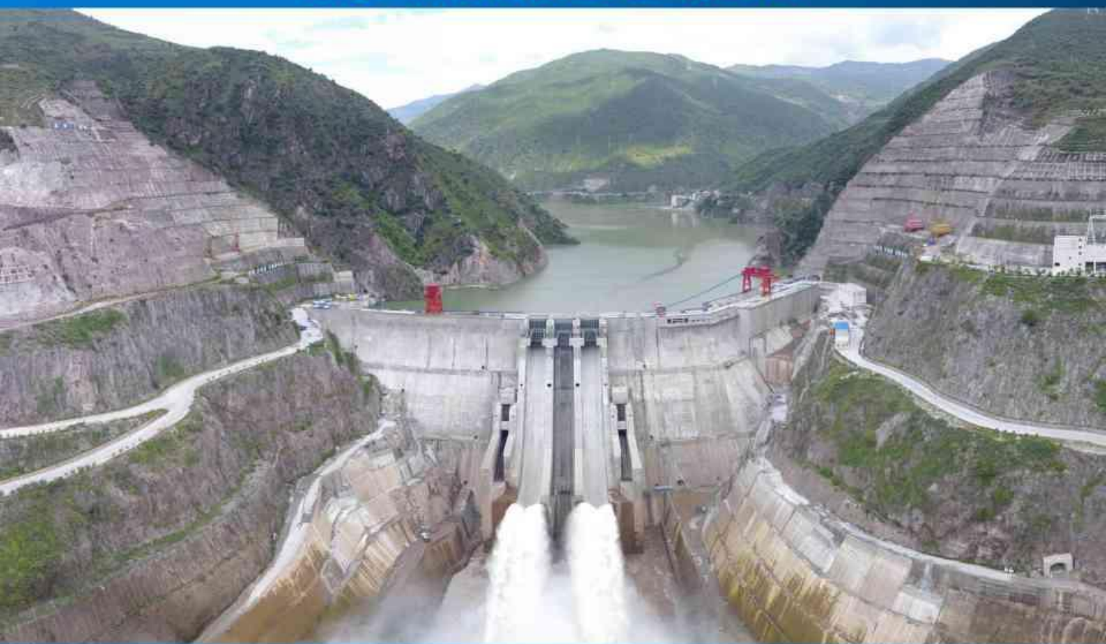
2018年4月建成的203m黄登RCC重力坝
